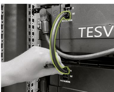
Connectez le raccord « OUT » de rack d'équilibrage (22) du premier module de batterie situé sous l'APU HV1000-S à l'aide d'un connecteur modulaire de rack équilibrage (4.3) au raccord « IN » de rack d'équilibrage (21) du module de batterie suivant situé dessous. Répétez cette opération pour tous les modules de batteries de la moitié gauche de l'armoire.
