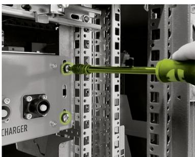
Insérez l'APU HV1000-S dans la moitié gauche de l'armoire sur la glissière la plus haute et fixez les vis à tête plate M6 x 16 (cruciforme) fournies (I) avec rondelle en plastique (II) aux écrous cage préinstallés (J).
