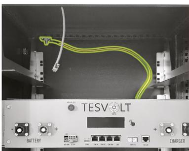
Fixez l'extrémité de la cosse de câble annulaire M8 au point de mise à la terre central (L). Utilisez une clé dynamométrique avec un couple de serrage de 10 Nm. Pour faciliter l'installation, vous pouvez placer temporairement l'APU HV1000-S sur les glissières du premier module de batterie.
