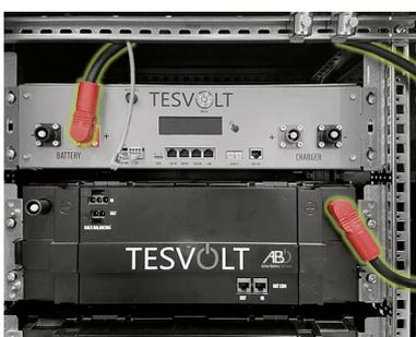
Los módulos de baterías del TS HV70 se interconectan en serie. Los colores de los conectores deben coincidir de manera obligatoria con los colores de las hembrillas del módulo de la batería, es decir, conector rojo a hembrilla roja, por ejemplo. Empiece en la parte izquierda del armario con la APU HV1000-S y el primer módulo de batería, así como la línea de conexión (3.1).
