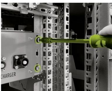
Colocar la APU HV1000-S en la mitad izquierda del armario en los carriles de deslizamiento superiores y fijarla con los tornillos de cabeza plana M6 x 16 (I) (Phillips) suministrados en el paquete adicional con arandelas de plástico (II) en las tuercas enjauladas montadas de fábrica (J).
