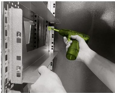
Ahora monte los otros tres herrajes de montaje (H) en los perfiles del armario en la parte trasera del mismo, cada uno a la misma altura que los herrajes de montaje delanteros ya instalados. Para el herraje de montaje de la parte inferior, el procedimiento es el mismo que para el montaje en los perfiles delanteros del armario. Sin embargo, en el caso de la unidad de ensamblaje central y superior del armario, quite primero en uno de los lados el carril de deslizamiento en el área de montaje.
