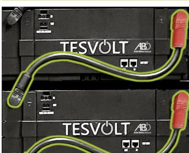
Instale las restantes líneas de conexión de CC (4.1) entre los módulos del lado derecho. Empiece por el módulo inferior.
