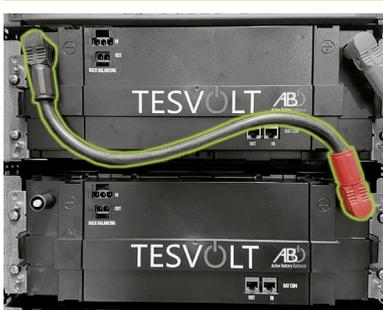
A continuación, conecte los restantes módulos de baterías en esta mitad del armario con las líneas de conexión de CC (4.1).
