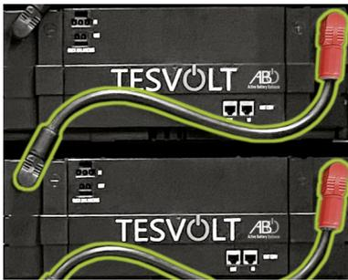
Installieren Sie die restlichen DC-Verbindungsleitungen (4.1) zwischen den Modulen der rechten Seite. Beginnen Sie dabei mit dem untersten Modul.
