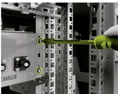
APU HV1000-S in der linken Schrankhälfte auf den obersten Gleitschienen einsetzen und mit den im Beipack mitgelieferten Flachkopfschrauben M6 x 16 (I) (Kreuzschlitz) mit Kunststoff-unterlegscheibe (I.I) an den vormontierten Käfigmuttern (J) befestigen.
