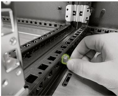
Für den Potenzialausgleich zwischen beiden Schrankhälften montieren Sie das Schrank-Erdungsverbindungsset (K). Setzen Sie dafür die Einsteckmuttern (K.5) von der Seite in die beiden mittleren Schrankprofile am Schrankboden. Die Position ist frei wählbar, jedoch müssen sich beide Einsteckmuttern direkt gegenüberliegen.
