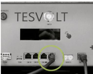
**LAN-Anschluss** (9) der APU HV1000-S mittels Patchkabel (7.4) mit einem der beiden von TESVOLT mitgelieferten Switch (8) über die mit „LAN“ beschriftete Buchse verbinden. Dieser Switch wird mit der Buchse „LAN 2“ des SMA Inverter Manager (10) verbunden und ab diesem Zeitpunkt als „LAN-2-Switch“ bezeichnet. An ihm wird auch noch der SMA STPS 60 angeschlossen (siehe Abschnitt „7 Anschluss am Batteriewechselrichter“ auf Seite 32 f.).
