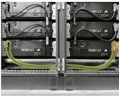
Verbinden Sie die untersten beiden Batteriemodule mit Hilfe der langen DC-Verbindungsleitung (5.1) aus dem Schrankverbinder-set (5).
