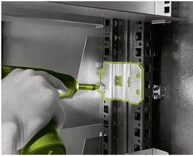
Befestigen Sie dann den mittleren und den oberen Schrankanreih über die Bohrungen an seiner Vorderseite mit Hilfe von vier Schrauben (H.2). Montieren Sie im Anschluss wieder die jeweilige Gleitschiene.
