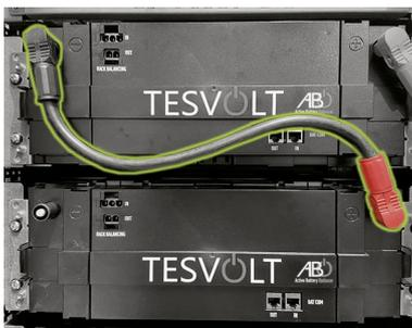
Verbinden Sie dann die übrigen Batteriemodule in dieser Schrankhälfte mit den DC-Verbindungsleitungen [4.1](#).
