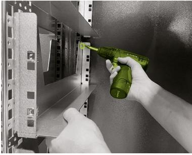
Montieren Sie jetzt die übrigen drei Anreihverbinder (H) an den Schrankprofilen der Schrankhinterseite, jeweils auf gleicher Höhe wie die bereits installierten vorderen Anreihverbinder. Bei dem Anreihverbinder unten entspricht das Vorgehen der Montage an den vorderen Schrankprofilen. Für den mittleren und oberen Schrankanreih müssen Sie jedoch zuerst auf einer Seite die Gleitschiene im Bereich der Montage entfernen.
