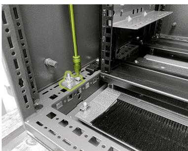
**Armário TS apenas:** Monte o ponto de aterramento em um ponto adequado no perfil da estrutura do armário (por exemplo, na frente, na parte inferior do perfil esquerdo da estrutura do armário). O ponto de aterramento (I) é fixado com a ajuda de dois parafusos autorroscantes ST5,5 x 12 (TX30) (I.I).
