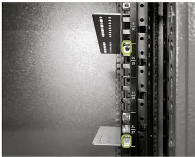
**Armário TS apenas:** Agora monte as porcas gaiola (E) para fixação dos módulos de bateria (Z) usando a ferramenta auxiliar (E.I). Distribua as porcas gaiola de baixo para cima. Comece na extremidade inferior do trilho deslizante do respectivo módulo de bateria. Instale as duas primeiras porcas gaiola na abertura diretamente acima em ambos os lados, deixe as próximas sete aberturas vazias e instale outro par de porcas gaiola na próxima abertura em ambos os trilhos do rack.
