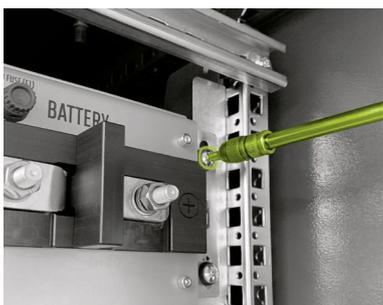
Insira o APU LV no trilho deslizante superior. Com os parafusos de cabeça chata M6 x 16 (D) (Phillips) fornecidos no pacote de acessórios, fixe nos quatro pontos de fixação as porcas gaiola pré-montadas com arruelas planas de plástico (D.1).
