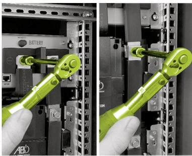
Agora aperte as porcas de flange (3.5) nas conexões BATTERY APU LV (11)/(12) com um torque de aperto de 12 Nm. Em seguida, os parafusos sextavados M8 x 20 (4.2) e também M8 x 16 (3.6) nas conexões CC dos módulos de bateria (17)/(18) devem ser apertados com um torque de aperto de 12 Nm.
