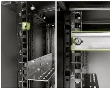
**Armário TS apenas:** Instale o trilho C (B) acima da posição do APU LV. Para fazer isso, instale as duas primeiras porcas gaiola (E) com a ajuda da ferramenta auxiliar (E.1) nos dois trilhos do rack no quarto orifício a partir da parte superior. Prenda o trilho C a ele com dois parafusos de cabeça chata M6 x 16 (D) (Phillips) e duas arruelas planas de plástico (D.1).
