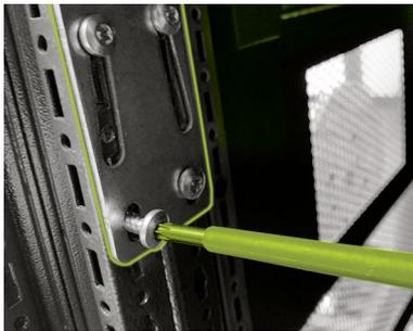
**Apenas extensão de armário TS:** Agora coloque dois parafusos de cabeça chata adicionais ST5,5 x 13 (K.2) nos pequenos orifícios do conector de armários.
