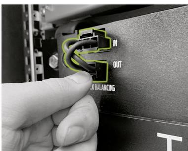
Agora você pode montar as pontes de balanceamento de rack (3.3)/(4.4). Use abaixo para o primeiro módulo APU LV a ponte de balanceamento de rack (3.3) do conjunto de conectores APU. As pontes de balanceamento de rack restantes (4.4) podem ser encontradas no conjunto de conectores do módulo.
