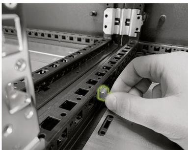
Montez le kit raccordement de mise à la terre de l'armoire (N) pour compenser le potentiel entre les deux moitiés de l'armoire. Pour ce faire, placez les écrous rapides M8 (N.5) du côté dans les deux profilés de cadre du milieu à la base de l'armoire. Vous pouvez choisir librement leur emplacement, mais les deux écrous rapides doivent être positionnés directement l'un en face de l'autre.
