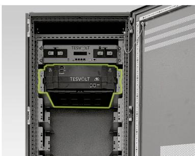
Montez le premier module de batterie en dessous de l'APU LV dans les glissières. Fixez-le à l'aide de deux vis à tête plate M6 x 16 (D) (cruciforme) et rondelles en plastique (D.1) aux écrous cage préinstallés.
