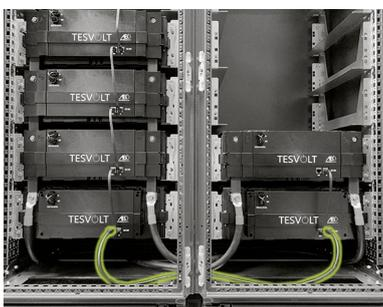
**Uniquement l'extension d'armoire :** à l'aide du câble de connexion (18.3), reliez le raccord BAT COM-OUT du module le plus bas à gauche au raccord BAT COM-IN du module le plus bas à droite. Reliez les raccords BAT COM restants des autres modules de batteries. Respectez également les spécifications de câblage de BAT COM sur le côté gauche de l'armoire lors des étapes d'installation suivantes.
