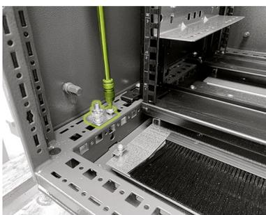
**Uniquement armoire TS :** reliez le point de mise à la terre à un emplacement approprié sur le profilé de cadre de l'armoire (par exemple à l'avant, en bas sur le profilé de cadre gauche de l'armoire). Le point de mise à la terre (I) est fixé à l'aide de deux vis autotaraudeuses ST5,5 x 12 (TX30) (I.1).
