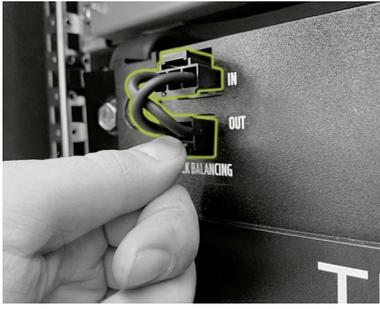
Vous pouvez à présent installer les ponts de rack d'équilibrage (3.3)/(4.4). Utilisez pour le premier module en dessous de l'APU LV le pont de rack d'équilibrage (3.3) du kit de connecteurs d'APU. Les autres ponts de rack d'équilibrage (4.4) sont disponibles dans le kit de connecteurs modulaires.
