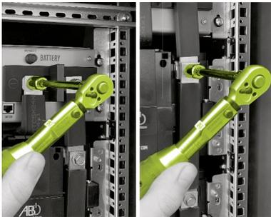
Serrez les écrous de blocage (3.5) sur les raccords BATTERY de l'APU LV (11)/(12) au couple de 12 Nm. Les vis hexagonales M8 x 20 (4.2) et M8 x 16 (3.6) peuvent ensuite être serrées sur les raccords DC des modules de batteries (17)/(18) au couple de 12 Nm.
