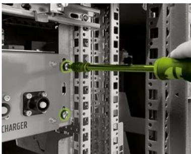
Inserte la APU HV1000-S en los carriles de deslizamiento superiores de la mitad izquierda del armario. Utilice los tornillos de cabeza plana M6 x 16 (I) (Phillips) y las arandelas de plástico (I.1) para fijar la APU HV1000-S a las tuercas enjauladas instaladas de fábrica.
