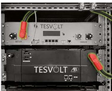
Los módulos de batería del TS HV80 están interconectados en serie. El color de las clavijas debe concordar con el color de las hembrillas del módulo de batería, es decir, la clavija roja va con la hembrilla roja. Comience por el lado izquierdo del armario con la APU HV1000-S y el primer módulo de batería con la línea de conexión (3.1).
