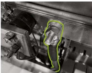
Conecte el cable conductor de protección al carril de compensación de potencial a través de los tornillos de contacto M10 o M12 ya ensamblados **B1**. Este se encuentra situado inmediatamente a la derecha del carril N. El par de apriete es de 40 Nm para las conexiones M10 y de 70 Nm para las conexiones M12 (utilice una llave inglesa para evitar que los tornillos giren al apretarlos).
