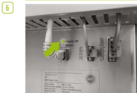
Cierre el conmutador principal S1 (23). En primer lugar, se prueban los ventiladores del TESVOLT PCS. Una vez se haya completado el test propio, el LED superior "Supply OK" de la IPU se ilumina en verde y el TESVOLT PCS está en funcionamiento.
