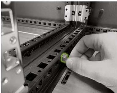
Coloque el juego de conexión de puesta a tierra del armario (M) para igualar el potencial de las dos mitades del armario. Para ello, inserte las tuercas rápidas (M.5) desde el lateral hacia el centro de los dos perfiles de la base del armario. La posición puede elegirse libremente, pero ambas tuercas rápidas deben estar contrapuestas.
