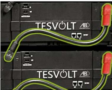
Instale el resto de líneas de conexión de CC (4.1) entre los módulos del lado derecho. Comience por el módulo inferior.
